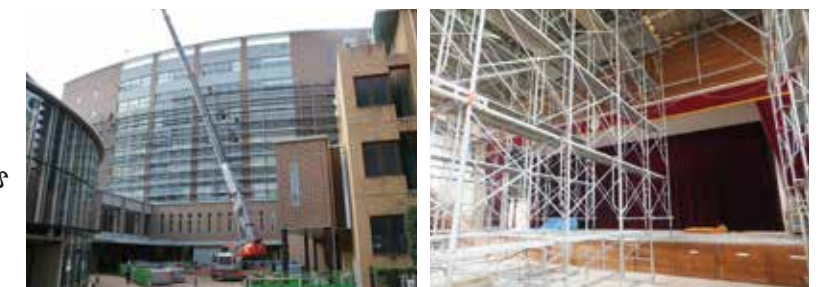
災害復旧工事
