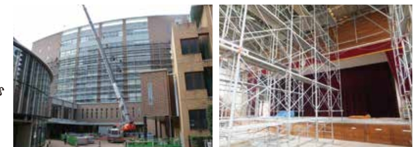
災害復旧工事
