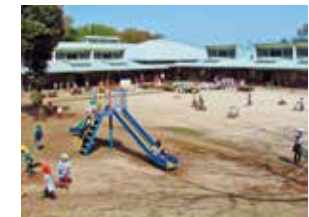
附属幼稚園園舎
