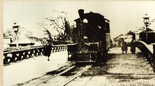
安巳橋の上を走る軽便鉄道【写真集熊本100年】熊本日日新聞社 ※軽便鉄道…石炭を焚き蒸気機関で軌道を走る小型の鉄道車両
